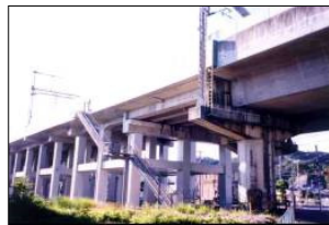
多径間連続RCラーメン橋
